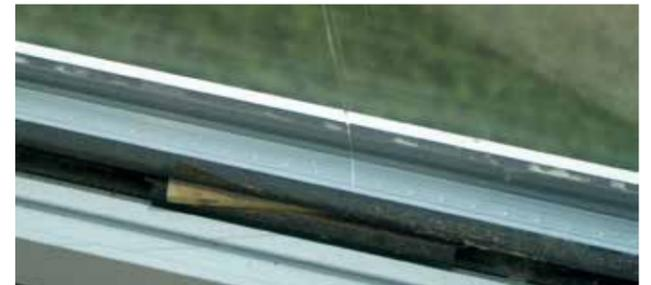
Fehlerquelle: Der schräg liegende Klotz führt zu Rissen im Glas.
