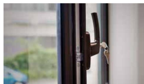
Die leistungsstarke Alternative: Der Roto AL 540 überzeugte den Gutachter hinsichtlich Funktionalität, Sicherheit und Preis. Durch leichte Anpassungen der Profile fügt sich der neue Beschlag perfekt in die existierenden Aluminiumfenster.
