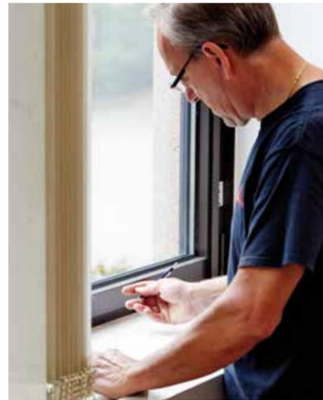
Roto Anwendungstechniker Günter Cornelius schulte die Montageteams vor Ort, insbesondere im Umgang mit den von Roto zur Verfügung gestellten Schablonen zum Vorbohren und Ablängen des Roto AL 540.
