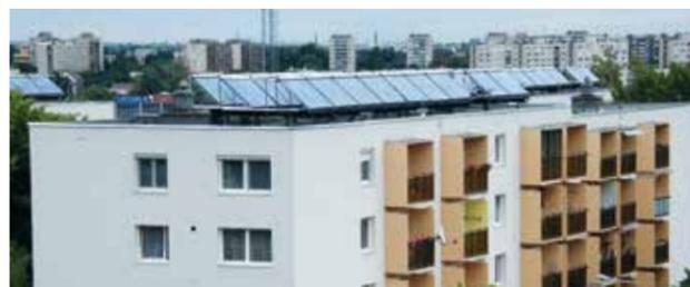
Seit 2011 sanierte die Fehérép Kft. bereits sechs von acht viergeschossigen Wohngebäuden in Budapests XI. Bezirk im Auftrag der Eigentümergemeinschaften. Die Fassaden wurden mit einer 10 cm dicken Dämmung versehen. Die modernen Fenster von Fehér Ablak schützen mit einem U-Wert von 1,3 W/m<sup>2</sup>K vor Wärmeverlusten. Rund 50 Prozent des im Haus genutzten Warmwassers werden heute von einer Solaranlage erzeugt.
