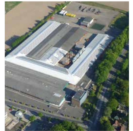
Im rekord-Werk in Dägeling, rund 50 km nordwestlich von Hamburg, werden circa 55.000 Fenstereinheiten pro Jahr gefertigt.
