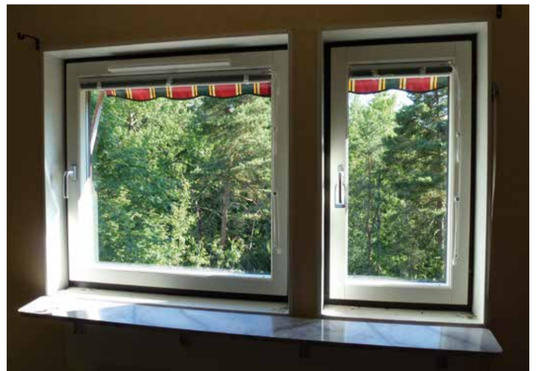
2012 entstand bei Windoor Sverige der Plan, ein neues, nach innen öffnendes Fenstersystem mit verdeckt liegenden Beschlägen zu entwickeln. Als erster Hersteller in Schweden wollte Windoor Sverige mit dem Modell „WinOne“ ein Dreh-/Kippfenster speziell für die Renovierung anbieten, das auch bei beengten Platzverhältnissen eingebaut werden kann.
