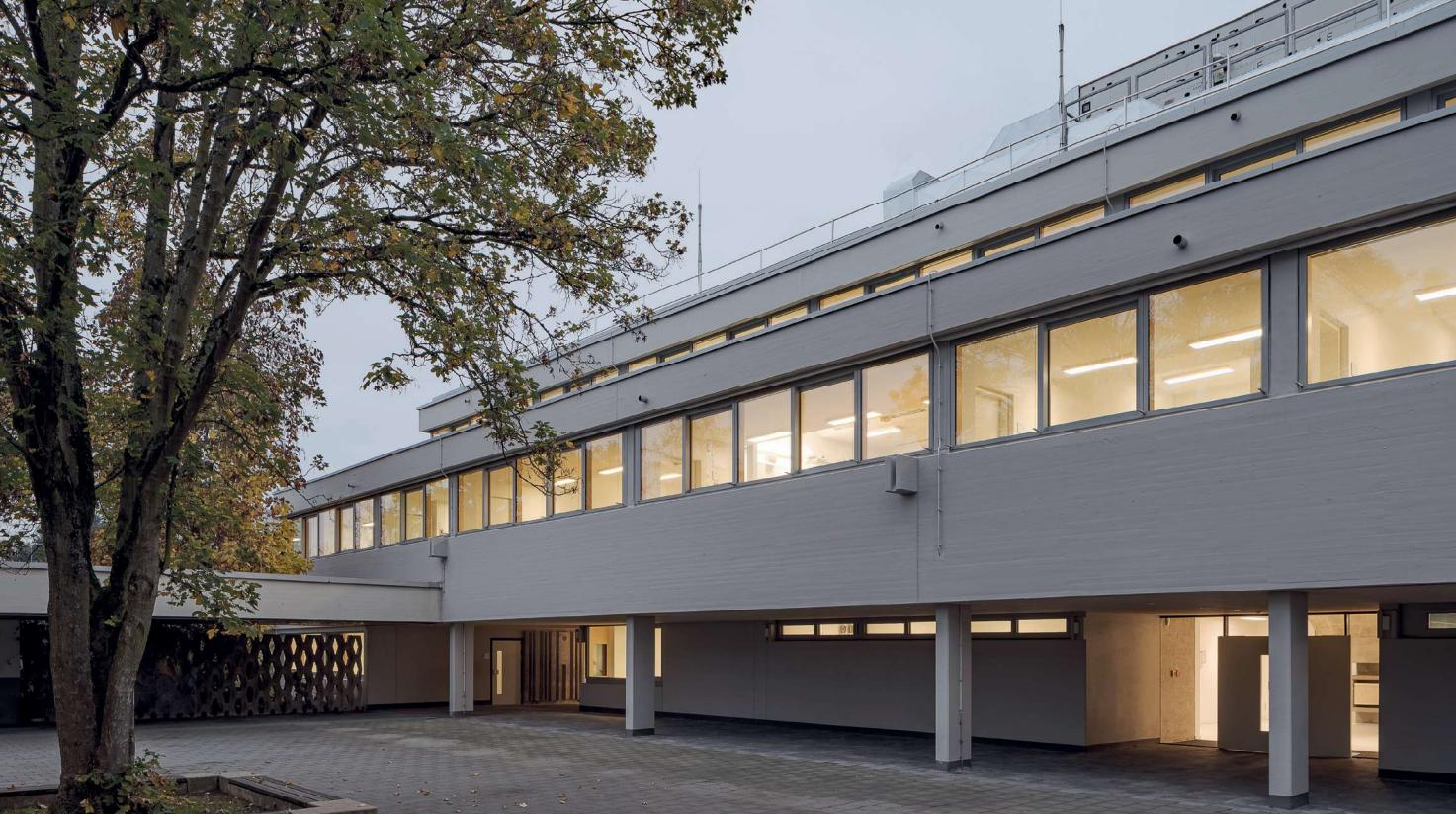
Der Bauteil B der Otto-Hahn-Gesamtschule in Frankfurt am Main wurde 2024 saniert und erhielt wartungsarme Schiebe-Fenster und Festverglasungen aus Fichtenholz mit einer Außenschale aus Aluminium.
