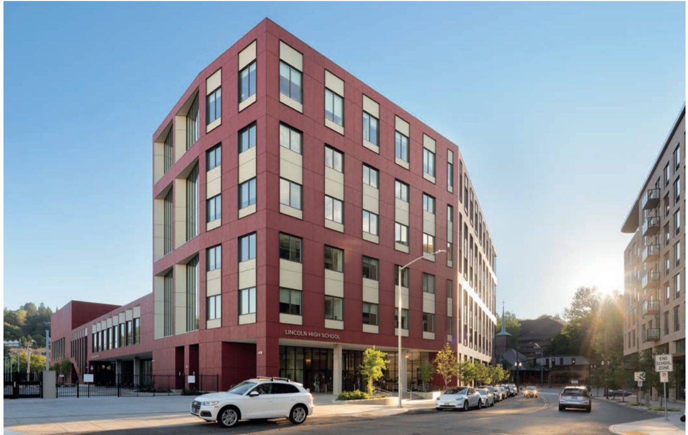
En el edificio nuevo del instituto de secundaria Lincoln High School en Portland, Oregón, EE. UU., se han incorporado ventanas abatibles y acristalamientos fijos de Cascadia.
