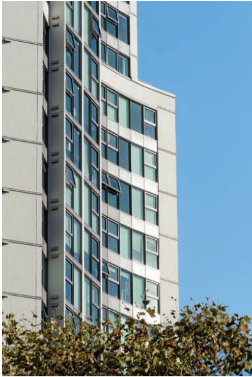
Cascadia y Roto apoyan a sus clientes con soluciones óptimas como estas ventanas de alta hermeticidad en "Pacific Point II Reha" en Vancouver, Columbia Británica, Canadá.
