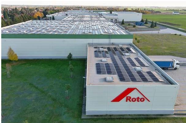
El suministro energético autosuficiente es una de las principales razones por las que Roto Fenster- und Türtechnologie mantiene su alta fiabilidad estable frente a sus clientes. De este modo, a principios de junio de 2024 se puso en funcionamiento una planta fotovoltaica de 7.200 metros cuadrados en la cubierta de la planta de producción de Lövő en Hungría.
