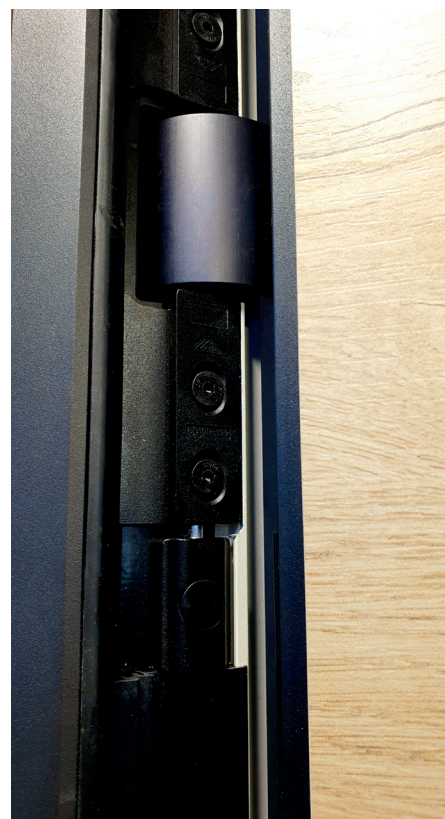
Technik stützt Design: das verdeckt liegende Türband Roto Solid C in schwarz. Foto: Roto
